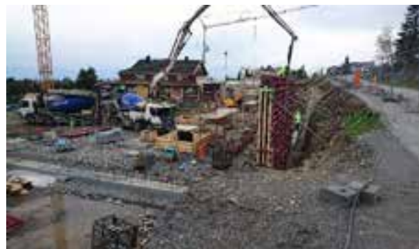
Fra byggearbeidene på Graaten
